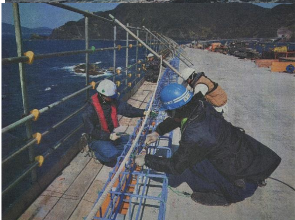
橋りょう用防護柵の工事に汗を流す作業員。10月初旬の開通を目指して追い込みの作業が続く
